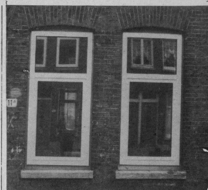
Een typische kleine beurt gevel. Herkenbaar aan de witte kunststoframen met isolerend glas.
