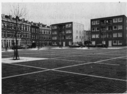
Een vergezicht over het nieuwe Zijdewindeplein. De bankjes en straatverlichting moeten nog aangelegd worden.
