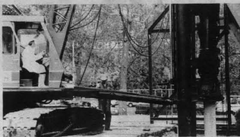
Op maandag 26 mei heeft mevrouw Stingl de eerste paal geslagen voor de herbouw van het pand Westersingel 9. Hier zal over ongeveer een jaar het Goethe-Instituut gevestigd worden dat nu nog op de 's Gravendijkwal zit.
