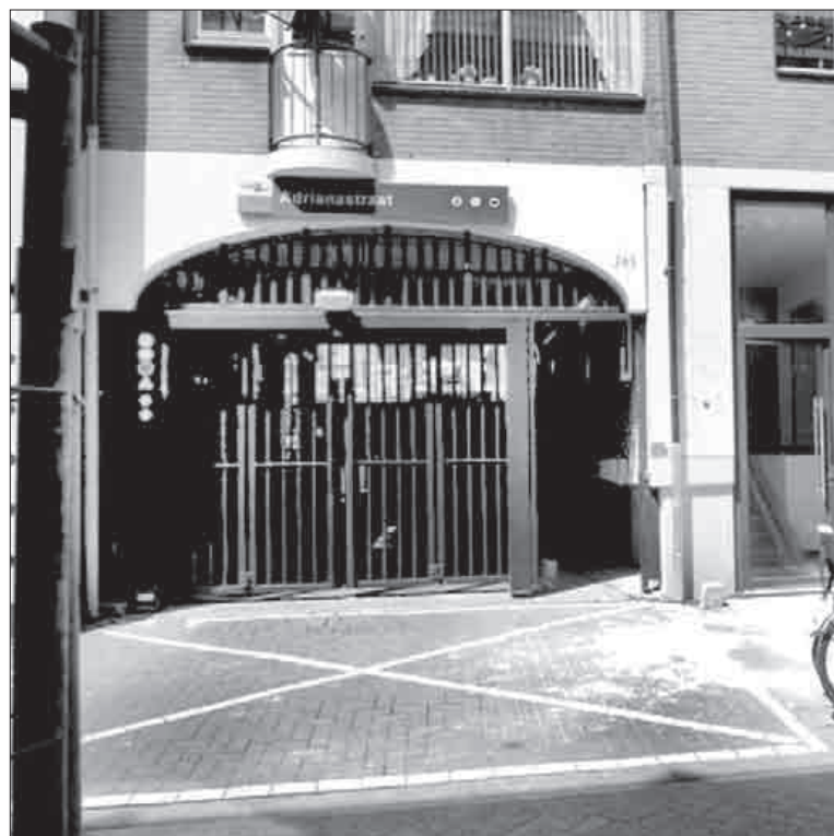
Parkeergarage Adrianastraat na renovatie
