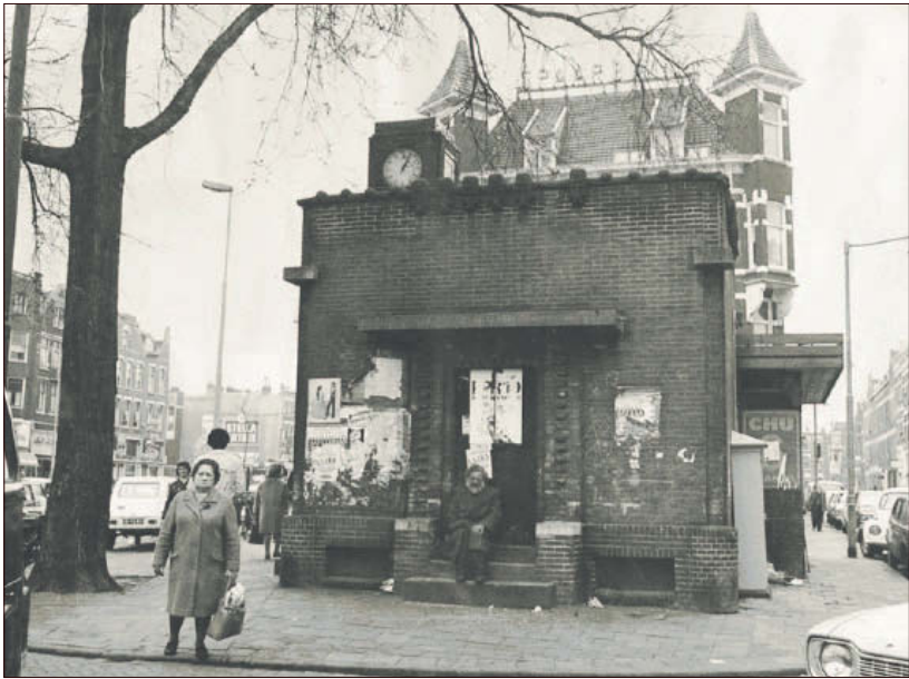
Het transformatorhuisje op een foto uit 1972 (archief Aktiegroep Het Oude Westen)
