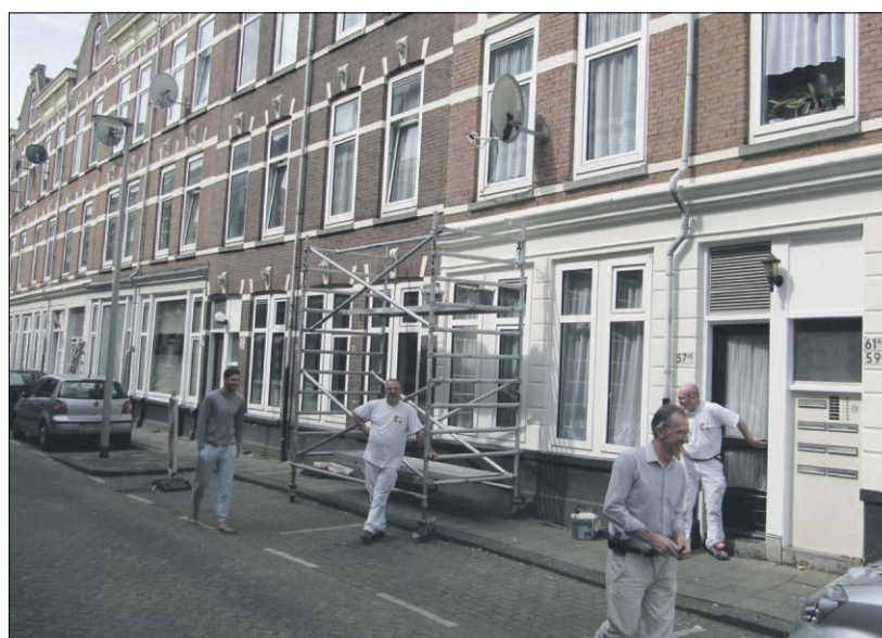
Opknappen gevels en portieken
