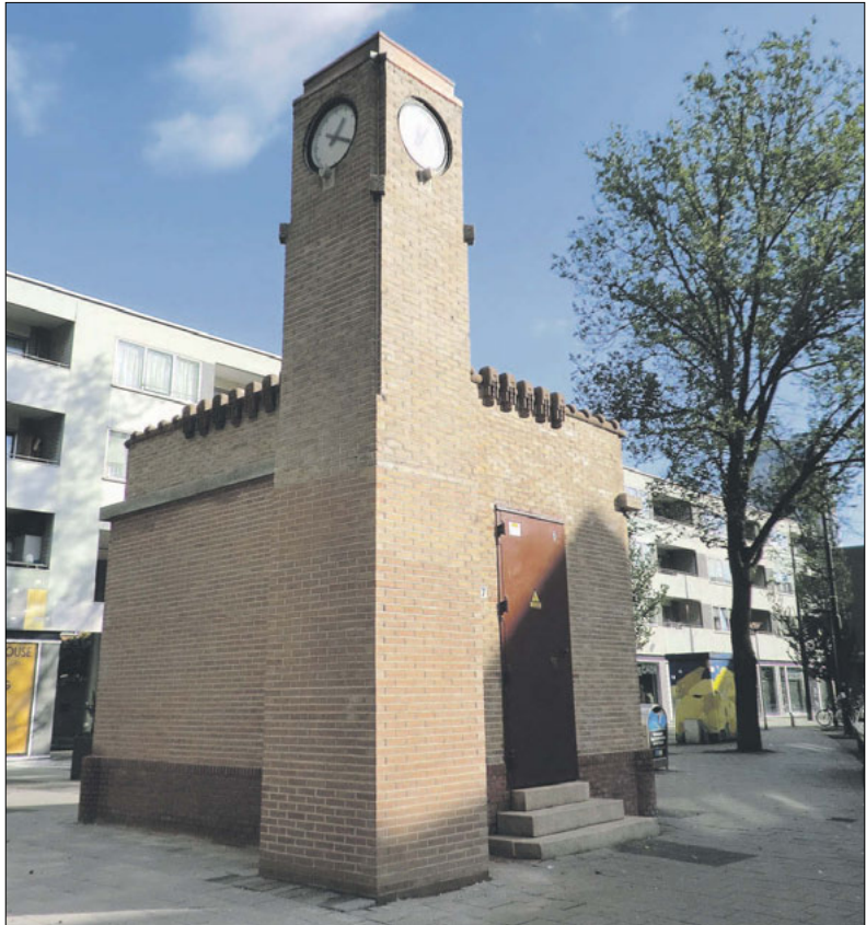
Historisch Electriciteitshuisje op het Tiendplein opgeknapt Netbeheerder Stedin heeft de restauratie van een historisch elektriciteitshuisje op het Rotterdamse Tiendplein afgerond. Daarmee is het huisje teruggebracht in de authentieke staat uit de jaren twintig van de vorige eeuw. Van de twintig in kubistische, expressionistische stijl gebouwde huisjes bestaan er tegenwoordig nog acht, waarvan er al één is aangemerkt als beschermd historisch erfgoed.
