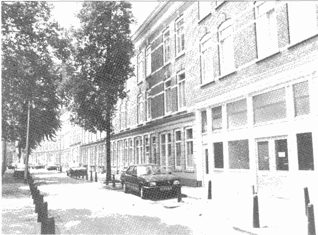
De Gaffelstraat na de renovatie
