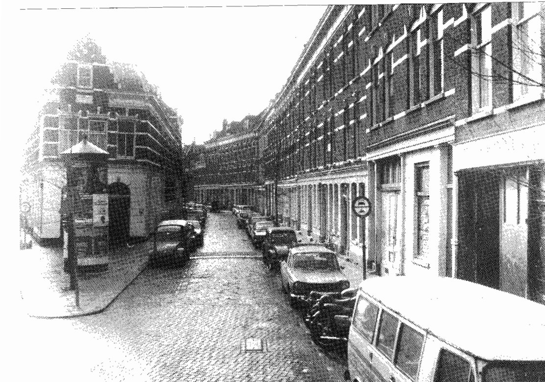
De Gaffelstraat voor de renovatie.
