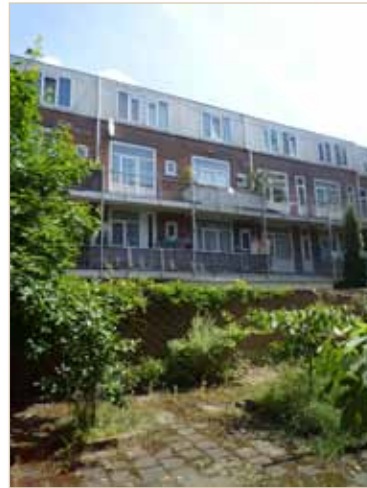
Achterzijde bebouwing Bajonetstraat
