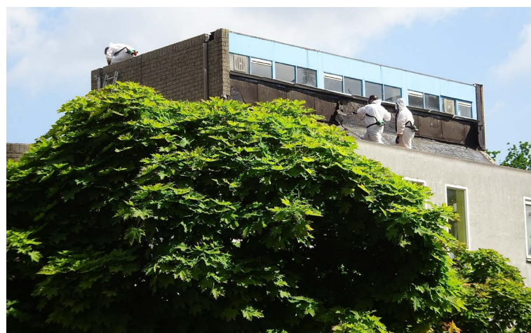
Op dit moment ligt de sloop van Odeon een beetje stil. De mannen hebben een lint gespannen met het bericht "Verboden toegang asbest". Die asbest zijn ze nu aan het verwijderen.
